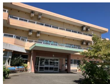
木更津市老健施設外観
