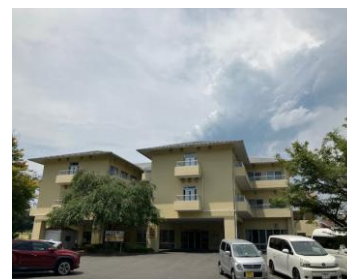
日光市老健施設外観
